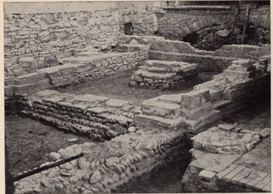
Blick vom südlichen Querhaus auf einen Teil des Vierungsquadrates und das Sanctuarium mit dem Fundament des romanischen Hauptaltars, vorne rechts Sandsteinplatte des rom. Fußbodens und Ziegel aus spätgotischer Zeit, davor Ansätze der Pfeiler und Säulen und Reste der östlichen Abschlußwand
