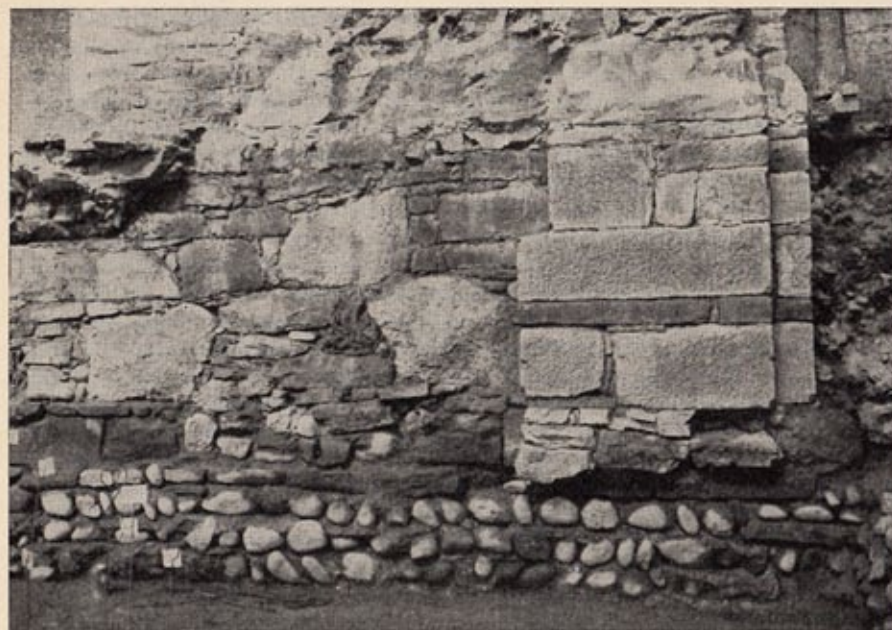
Blick auf die nördliche Innenwand vor dem Querhaus. Unten die fischgrätenähnliche Lagerung der Achbollen, darüber Plattenreste des romanischen Fußbodens, aufgehendes Mauerwerk der Barock-Kirche aus Bruchsteinen und Ansatz einer Barockklisene Aufnahme: Stadtarchivar E. Gmeiner
